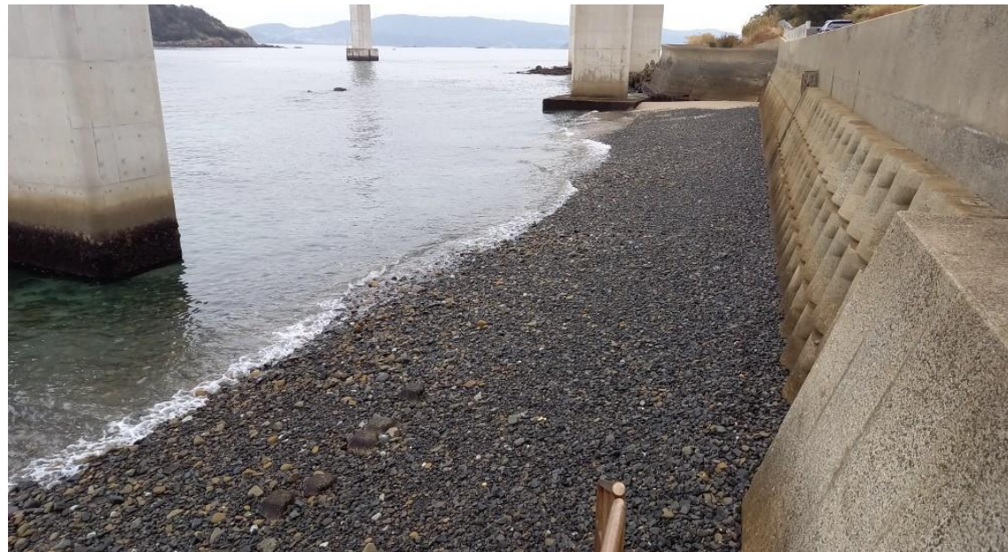
伊王島大橋の下 比較的ゴミが少ない
