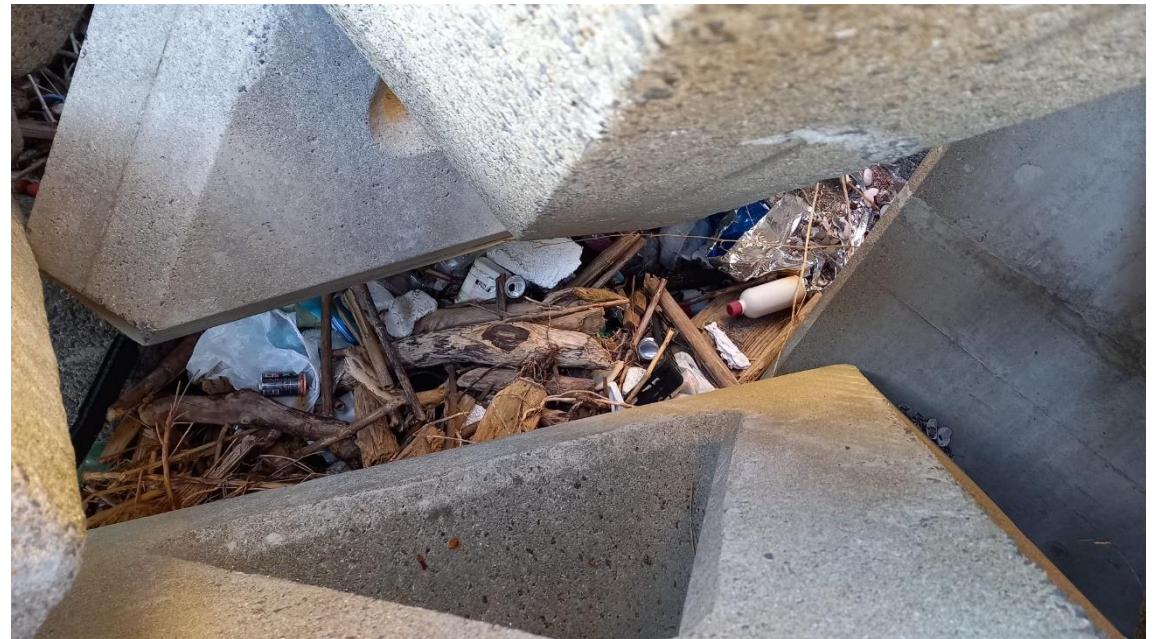
南串の国東半島の南側の消波ブロックの内側
